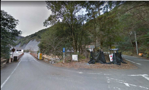
起点(国道265号からの接続箇所)
