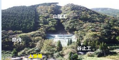
治山施設等の整備
