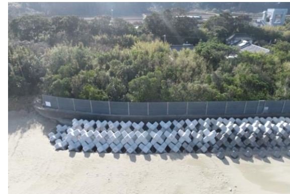
防潮工（消波工）
