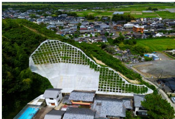
山腹工（法枠工）
