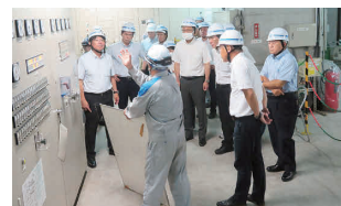
(小丸川発電所)
