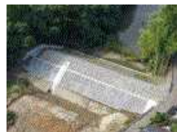
【ため池の補強対策工事】
