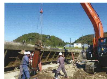
【農業用施設の対策工事】
