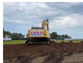
【防疫作業（埋却地）】
