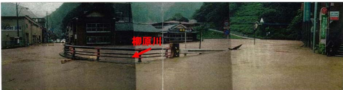
平成9年9月の被害状況(諸塚地区)
