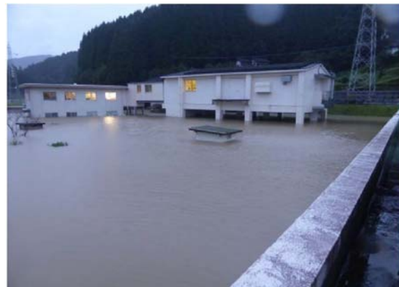
令和 4 年 9 月の被害状況(企業局浄水場)
