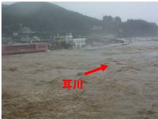
平成 17 年 9 月の被害状況(幸脇地区)
