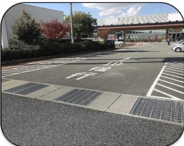
○路面標示による注意喚起
