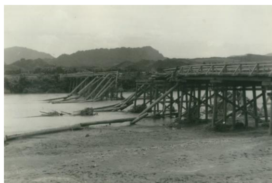
じょうし 上使橋崩壊 (宮崎市清武町)
