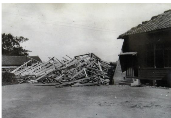
三財中学校倒壊 (西都市)
