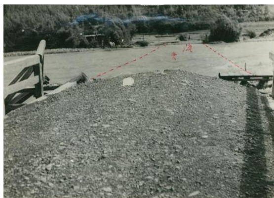
綾南川橋流失 (東諸県郡綾町)
