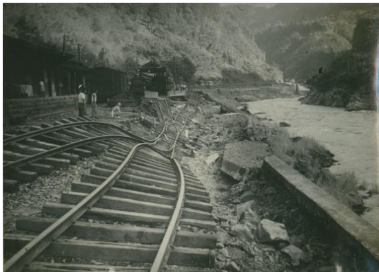
飴ようになったレール (日之影駅構内)
