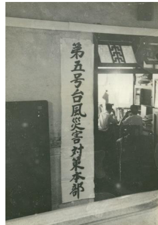
県庁内に設置された対策本部
