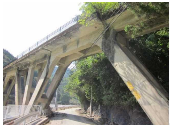
県道と旧日ノ影線が立体交差する地点（県道の手前側が延岡市側、向こう側が日之影町側）
