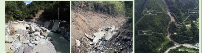
写真 小原地区における崩壊の発生状況
