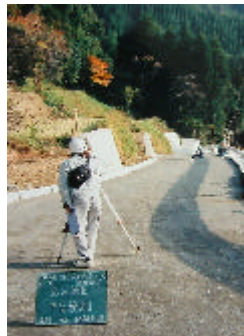
林道の勾配測定
