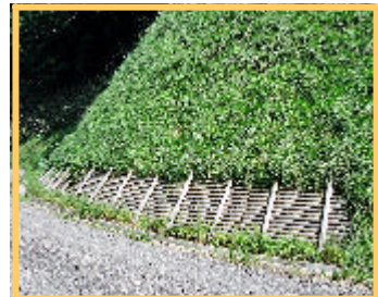
景観に配慮した法面が完成
