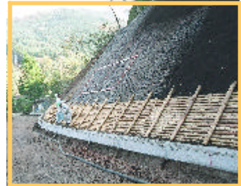
木材を利用した法面（のりめん）保護工
