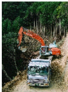
道なき山中に道をつくる工事現場の最前線
