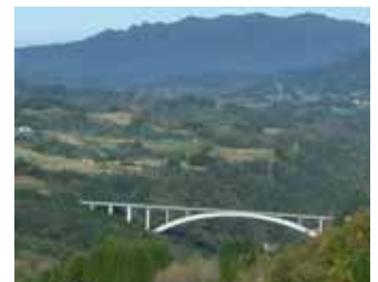
国見ヶ丘から撮影した国見大橋
