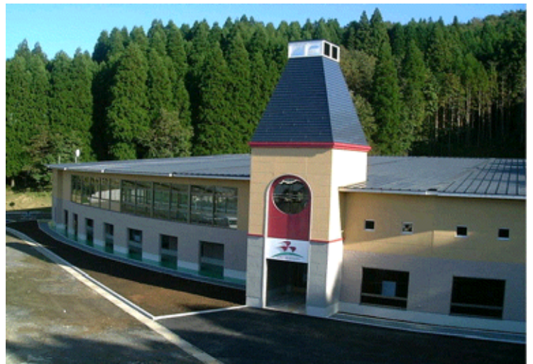
フェスタ会場の近くでは、五ヶ瀬町で生産されるぶどうを使用する「五ヶ瀬ワイナリー」の建設が、平成17年秋の本格稼働を目指して着々と進んでいます。
