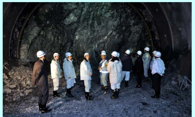
岩戸坂トンネル(仮称)の工事現場を視察する東国原知事
