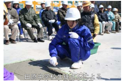
田原中学校生徒さんによるコンクリート打設の様子
