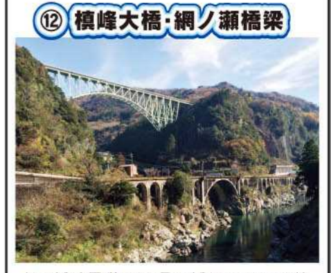
⑫ 横峰大橋・網ノ瀬橋梁 上の橋は国道218号の橋長330mの横峰大橋。下の網ノ瀬橋梁の42連続アーチと五ヶ瀬川のマッチングは素晴らしく見応えがあります!
