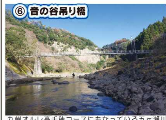
九州オルレ高千穂コースにもなっている五ヶ瀬川に架かる吊り橋。橋の上からの眺めは最高です。
