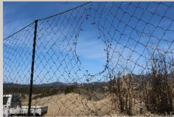
補修前ネット
