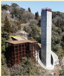
高千穂町側の橋脚(P1)
