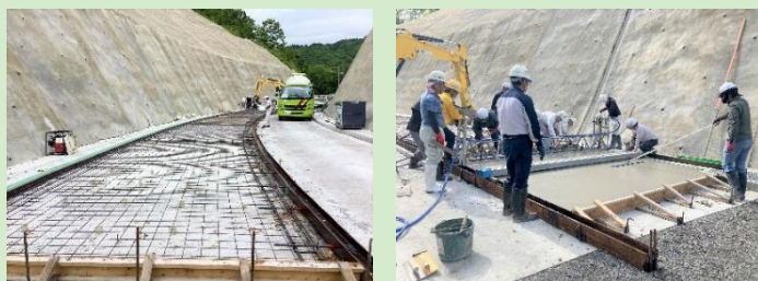
改良工事の様子(夕塩工区)
