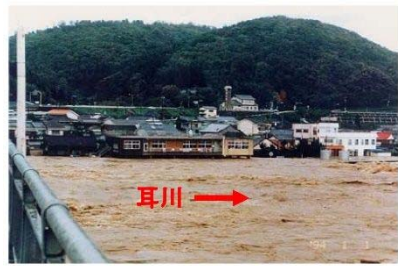
平成 9 年 9 月の被害状況(幸脇地区)
