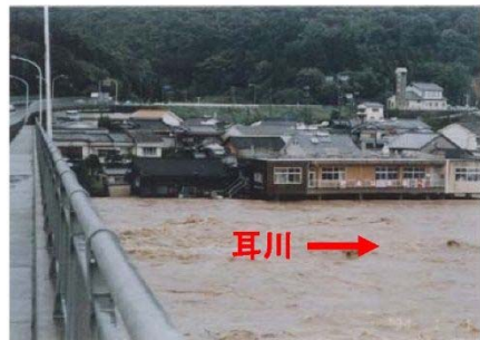
平成 16 年 8 月の被害状況(幸脇地区)
