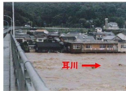
平成 16 年 8 月の被害状況(幸脇地区)
