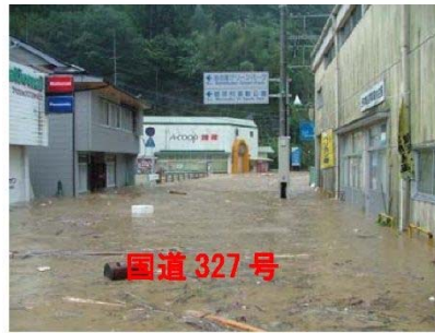
平成 16 年 8 月の被害状況(諸塚地区)
