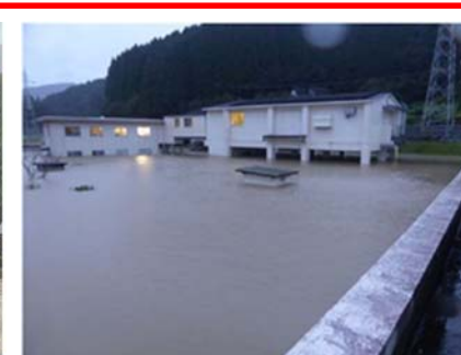
令和 4 年 9 月の被害状況 (企業局浄水場：日向市東郷町山陰)
