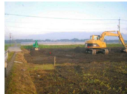
畦畔除去・整地工
