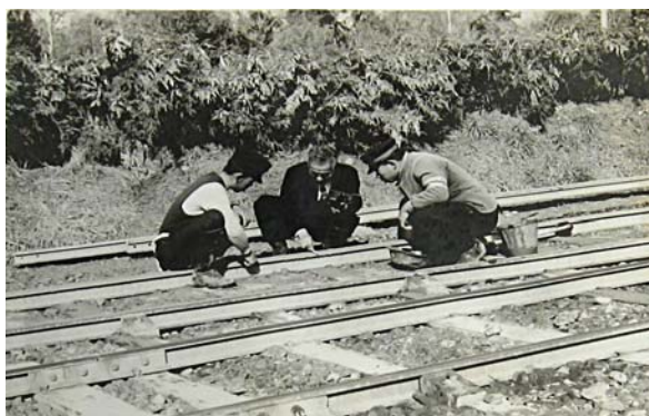
鉄道被害の状況 （「降灰による機械金属の被害状況及び其の対策について」添付）
