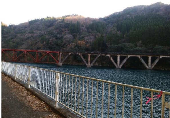
第三五ヶ瀬川橋梁 (R2.12.14 撮影)
