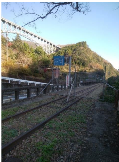
旧榎峰駅廃線敷(R2.12.14 撮影) 左上は日之影バイパス榎峰橋
