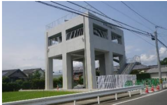
津波避難タワー（延岡市）
