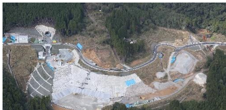
国道447号 真幸バイパス
