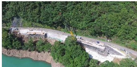
国道219号 越野尾二之渡工区
