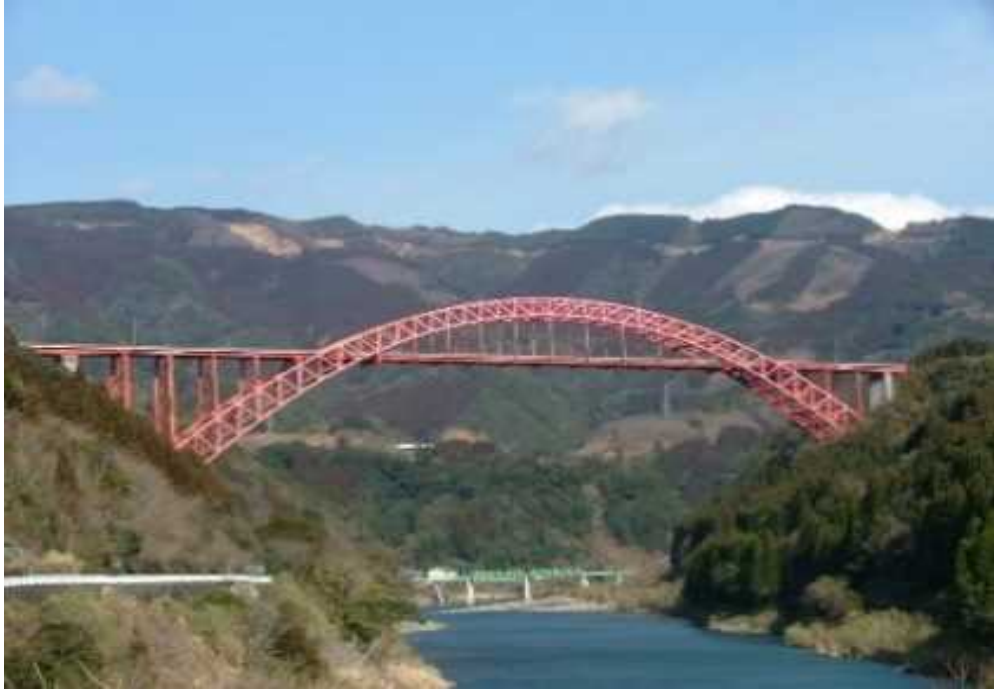
国道218号 干支大橋
