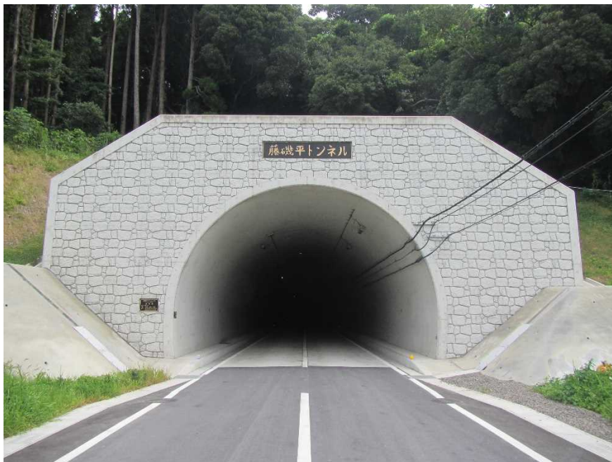
国道448号 藤磯平トンネル
