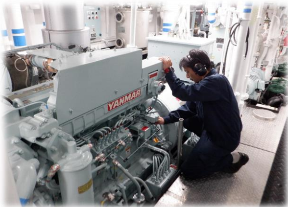
〈写真〉発電機の機関整備
