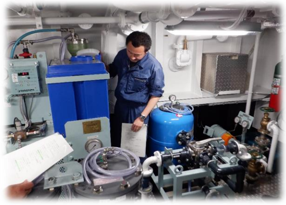
〈写真〉造水機の機関整備
