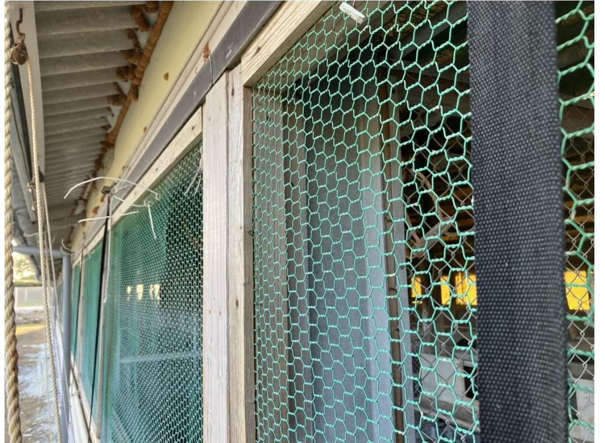
垂木及び胴縁で金網を設置（現状）
