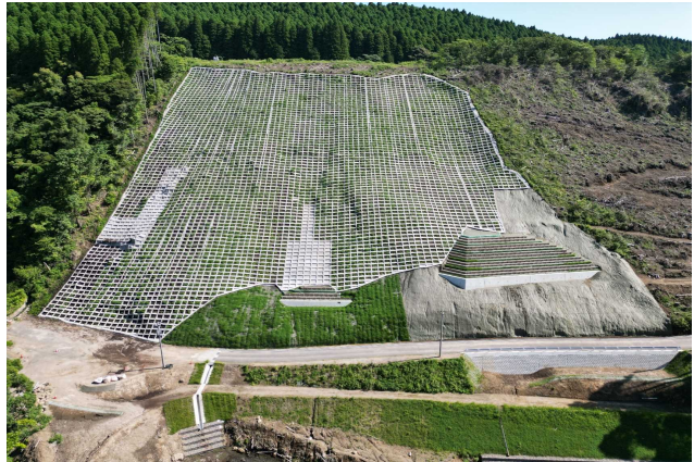
3-(2) 令和4年度災害関連緊急治山事業 亀野地区(高原町)
