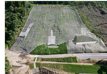
令和4年度災害関連緊急治山事業 亀野地区(高原町)
