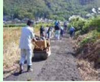
未舗装農道の舗装
