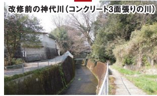
改修前の神代川(コンクリート3面張りの川)
