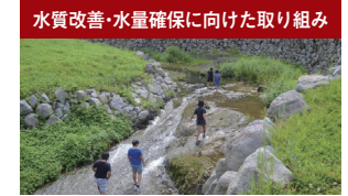
擬岩コンクリートによる川底の整備
