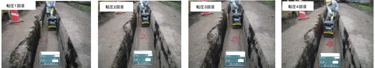
※ 簡素化 : 転圧回数毎の撮影は不要。一層毎の最終転圧時の転圧締め写真を撮影する。
