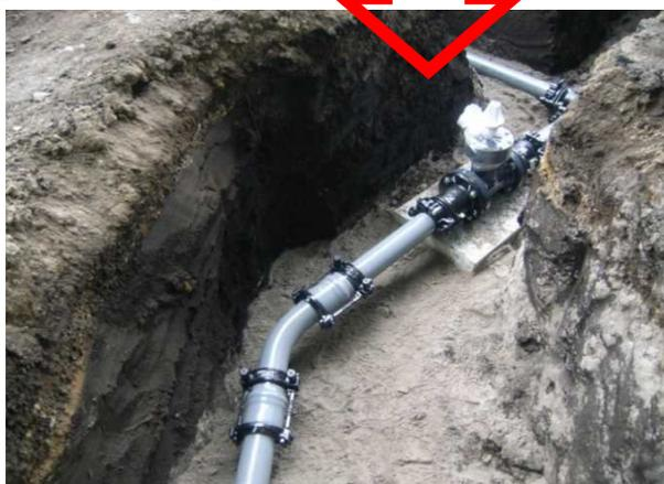
離脱防止金具、異形管、弁類が近接している場合等で、複数の接合部が1枚の写真に収まる(各接合部は明確に撮影)ように撮影されていれば、接合箇所毎に1枚ずつ撮影しなくてもよい。
