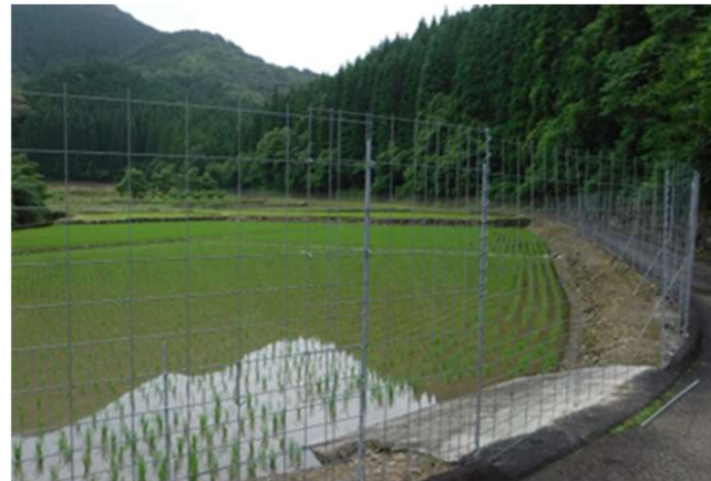
侵入防止柵の整備
