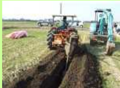
暗渠排水による湿田の解消
