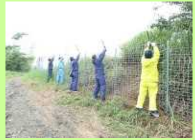
侵入防止柵の設置
