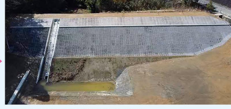
ため池等整備事業(危険ため池) 河ヶ池地区(日南市)
