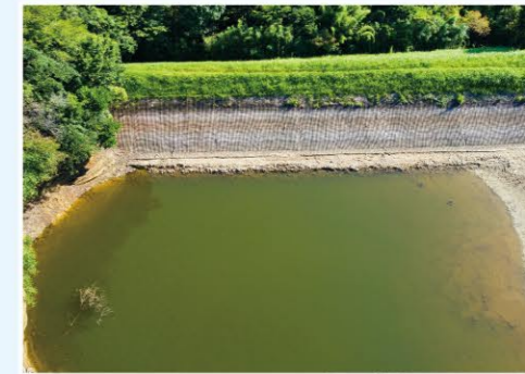
ため池等整備事業 山仁田地区(都城市)
