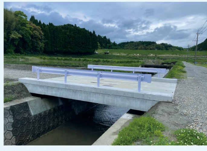
経営体育成基盤整備事業 大和地区(新富町)
