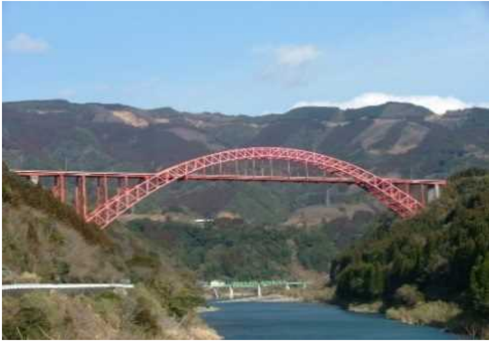
国道218号 干支大橋
