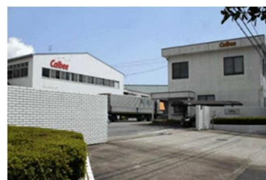
▲鹿児島工場の外観
