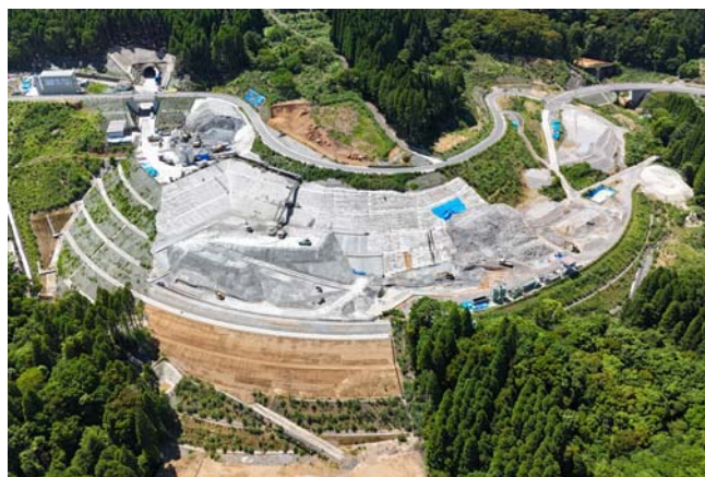
国道447号 真幸工区
