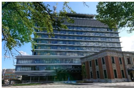
(宮崎県防災庁舎 全景)
