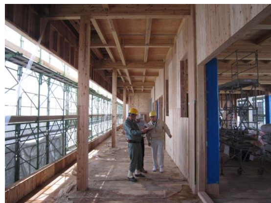
（小林市交流センター建設工事）
