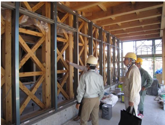
（小林市新庁舎建設工事）
