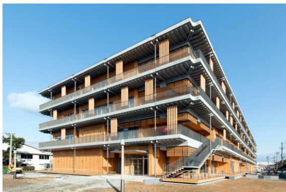
（日向市新庁舎 全景）
