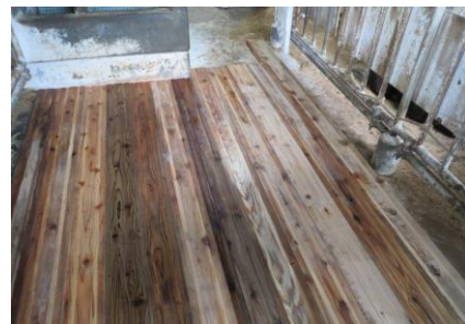
写真 1 スギ床材設置状況
