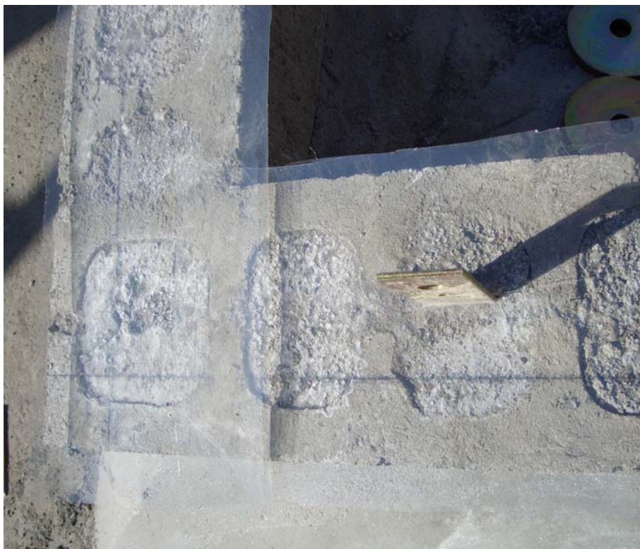
図3 フィルムバリアーを施工した基礎
