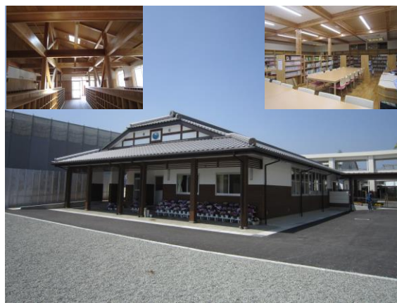
(小林市南小学校木造校舎)
