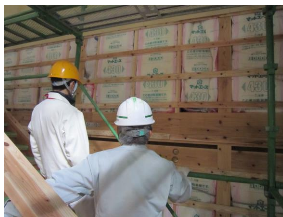
（綾町総合交流促進施設新館建設工事）
