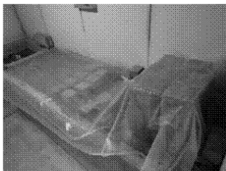
図1 ファンガスセラー内部の状況
