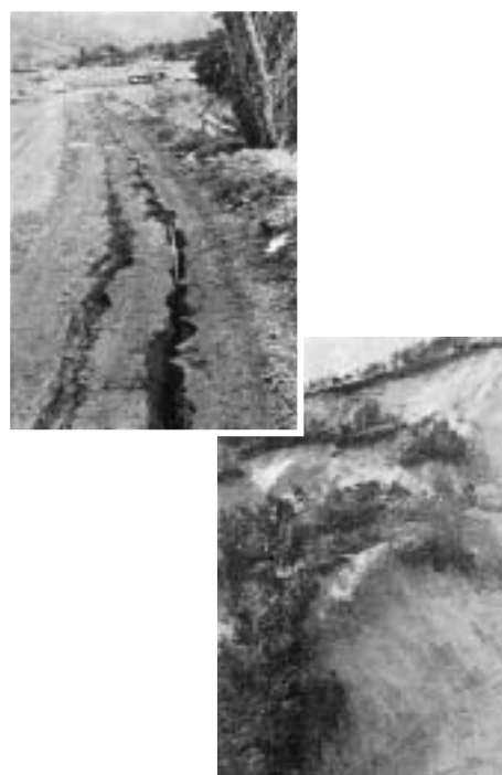
写真 2.2 (上) 地震による農道の地割れ(藤本,1971)
