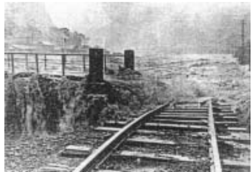
写真 4.4 流失直前の五ヶ瀬橋 (日之影町,2001 田邊晶昭氏提供)
