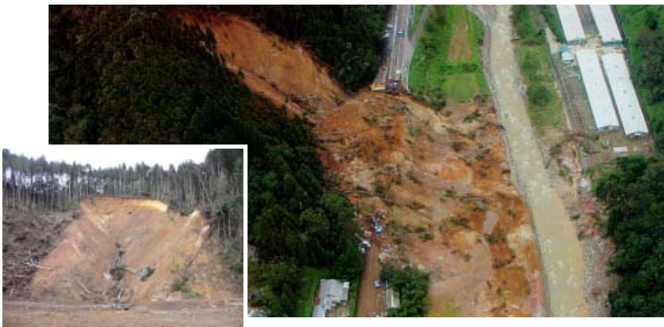
写真 4.34 山之口町五反田の崖崩れ
