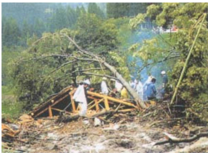
写真 4.14 高千穂町河内字栃屋の斜面崩壊
