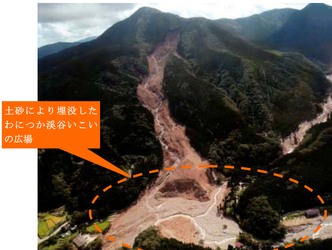
写真 4.36 別府田野川上流の崩壊状況
