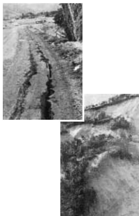
写真 2.2 (上) 地震による農道の地割れ(藤本,1971)
