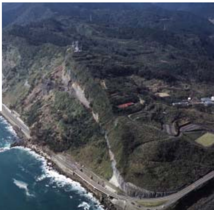
写真 4.27 日南市富士の地すべり全景(2004 年撮影)
