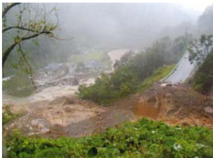
写真 4.26 西米良村 村道山瀬線(旧国道 219 号)決壊現場
