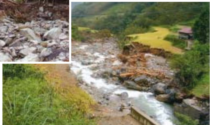
写真 4.23 椎葉村内の八重川の被災状況
