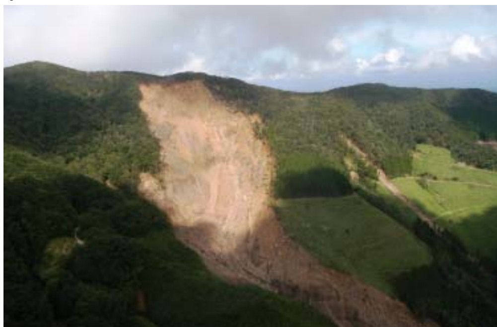
写真 4.37 境川上流部崩壊状況
