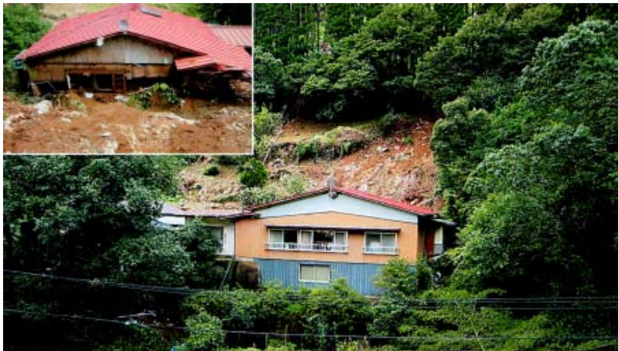
写真 4.28 高千穂町土呂久畑中の崖崩れ
